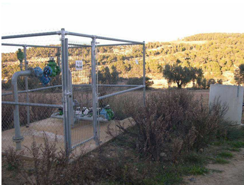
Foto 5. Una de les nombroses estacions de bombeig, amb la presa per a la finca del sector abastat.
